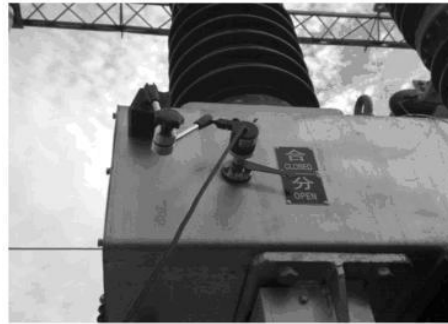
35KV SF6 开关传感器安装
