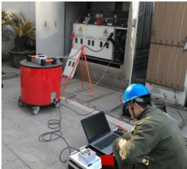
图 7-7 UHV-505 试验现场
